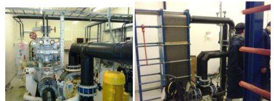
Un échangeur thermique permet de récupérer les calories de l'eau de rejet avant de chauffer l'eau des élevages.
