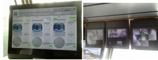
Une autre salle de commande à proximité de la salle des machines a pour fonction de visualiser et de contrôler les paramètres des cuves pour le transport des poissons ainsi que la qualité de l'eau pompée. Une filtration sur chaussette permet de filtrer l'eau et de récupérer les poux des saumons.
